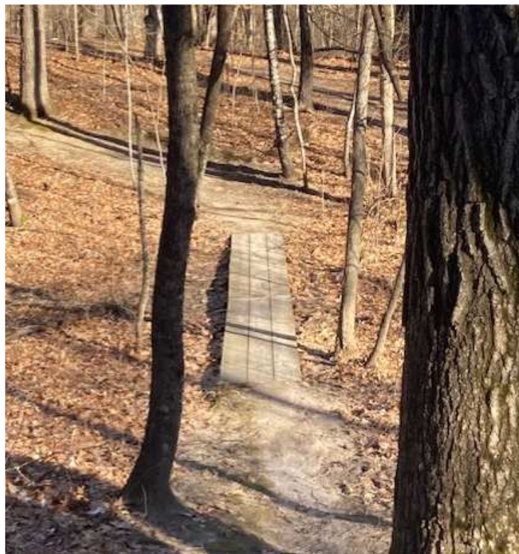
Wet Land Decking
